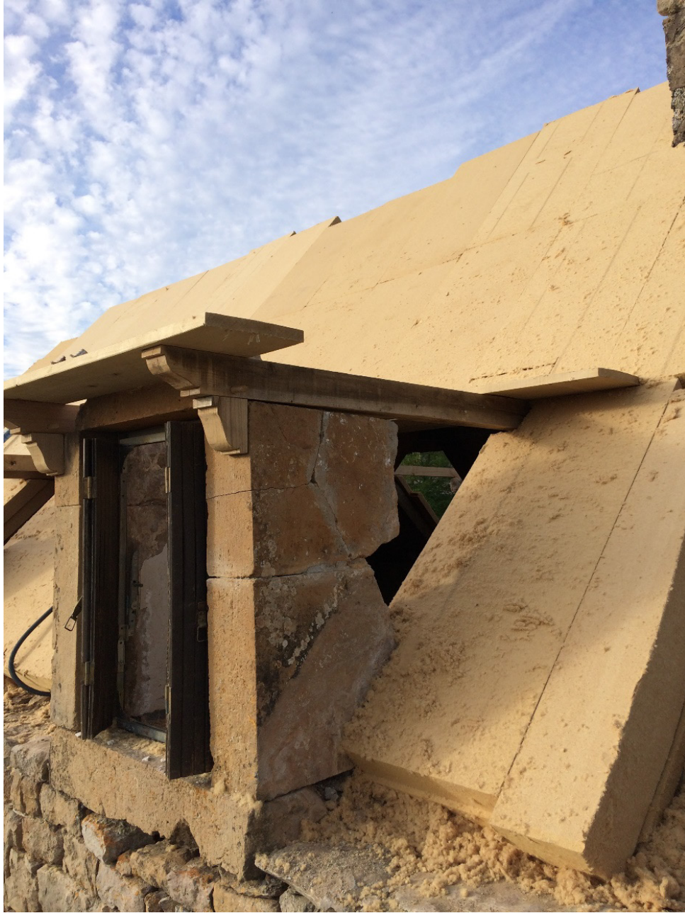
Isolation d'une toiture par l'extérieur en panneaux de fibres de bois RODELLE (12)
