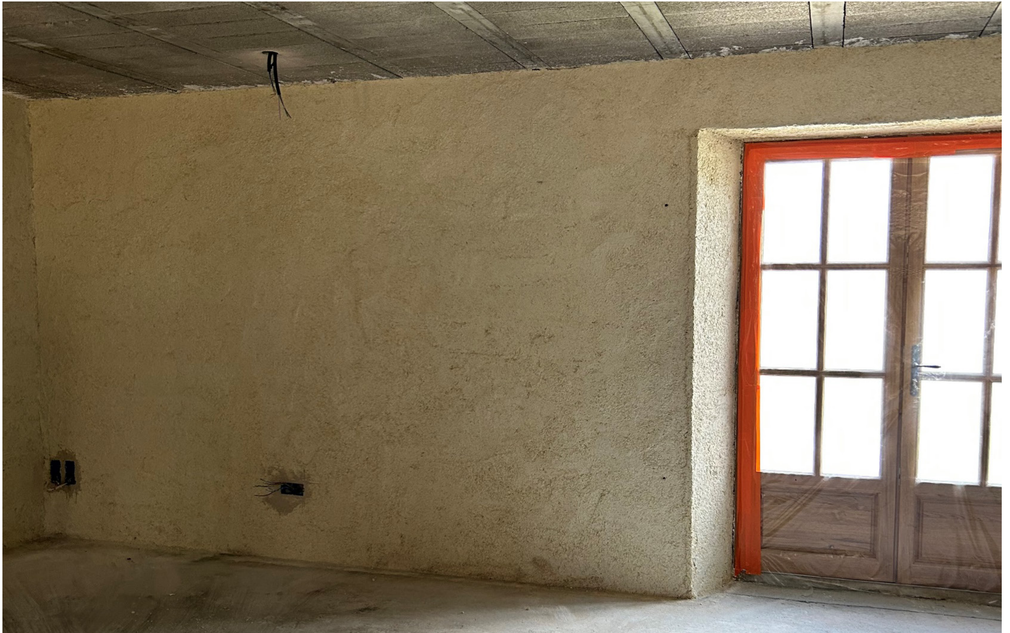
Isolation chaux-chanvre en cours de réalisation OLS & RINHODES (12)
