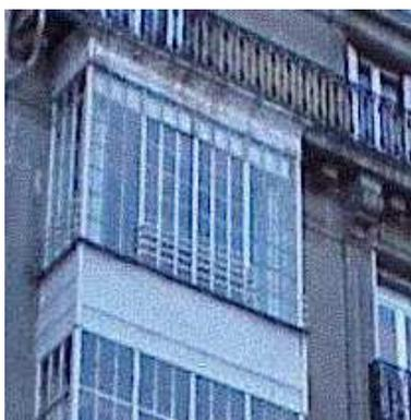
Le principe de fonctionnement est identique à celui des doubles fenêtres : créer un espace tampon actif entre l'intérieur et l'extérieur du logement. Ici, l'espace tampon prend simplement des dimensions plus grandes et vient prolonger un séjour par exemple.
