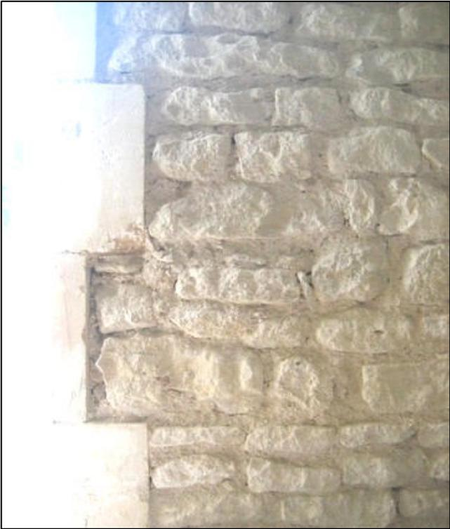
Les enduits intérieurs seront refaits à la chaux avec une finition plâtre pour certains. A l'extérieur les pierres de taille étant posées en saillie permettent la pose d'un enduit isolant (végétal ou minéral). Toutes les boiseries (portes, fenêtres, parquets) seront remplacées.
