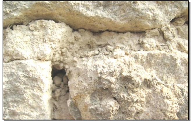
Le mortier de chaux qui lie les pierres entre elles est très fragilisé à l'extérieur comme à l'intérieur. Au toucher il se transforme en poudre, la chaux n'ayant plus de propriété mécanique.
